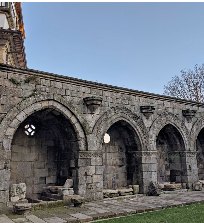
Fig. 5. Claustro Velho da Sé do Porto, onde se localizava a Capela de Santiago. Foto: L.P., 2020.
