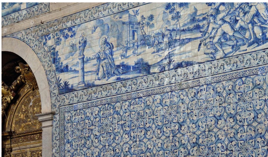
Fig. 9. Samora Correia, Igreja de Nossa Senhora da Oliveira, nave, revestimento do lado da Epístola, “73F2412 Maria aparece a Tiago sobre uma coluna (missão de Tiago)”, “73F24121 construção da Igreja de Nossa Senhora do Pilar por anjos” e combate com pedreiros. Fotografia: Luís Rocha, 2001, imagem cortada, https://pt.wikipedia.org/wiki/Ficheiro:Igreja_de_Nossa_Senhora_da_Oliveira_(Samora_Correia)_6.jpg
