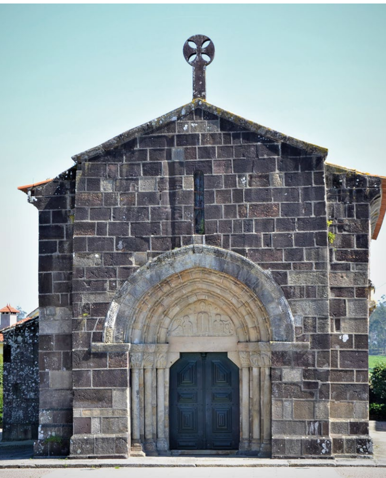
Fig. 9. Igreja de São Cristóvão de Rio Mau. Fachada principal. Foto: PAF.
