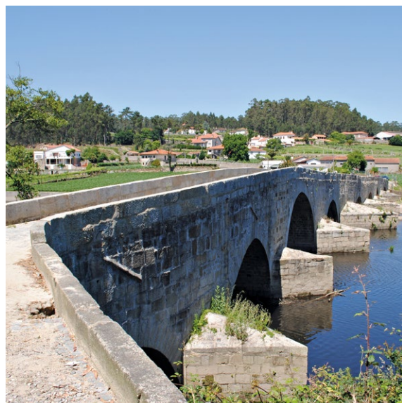
Fig. 7. Ponte de D. Zameiro. Foto: PAF.
