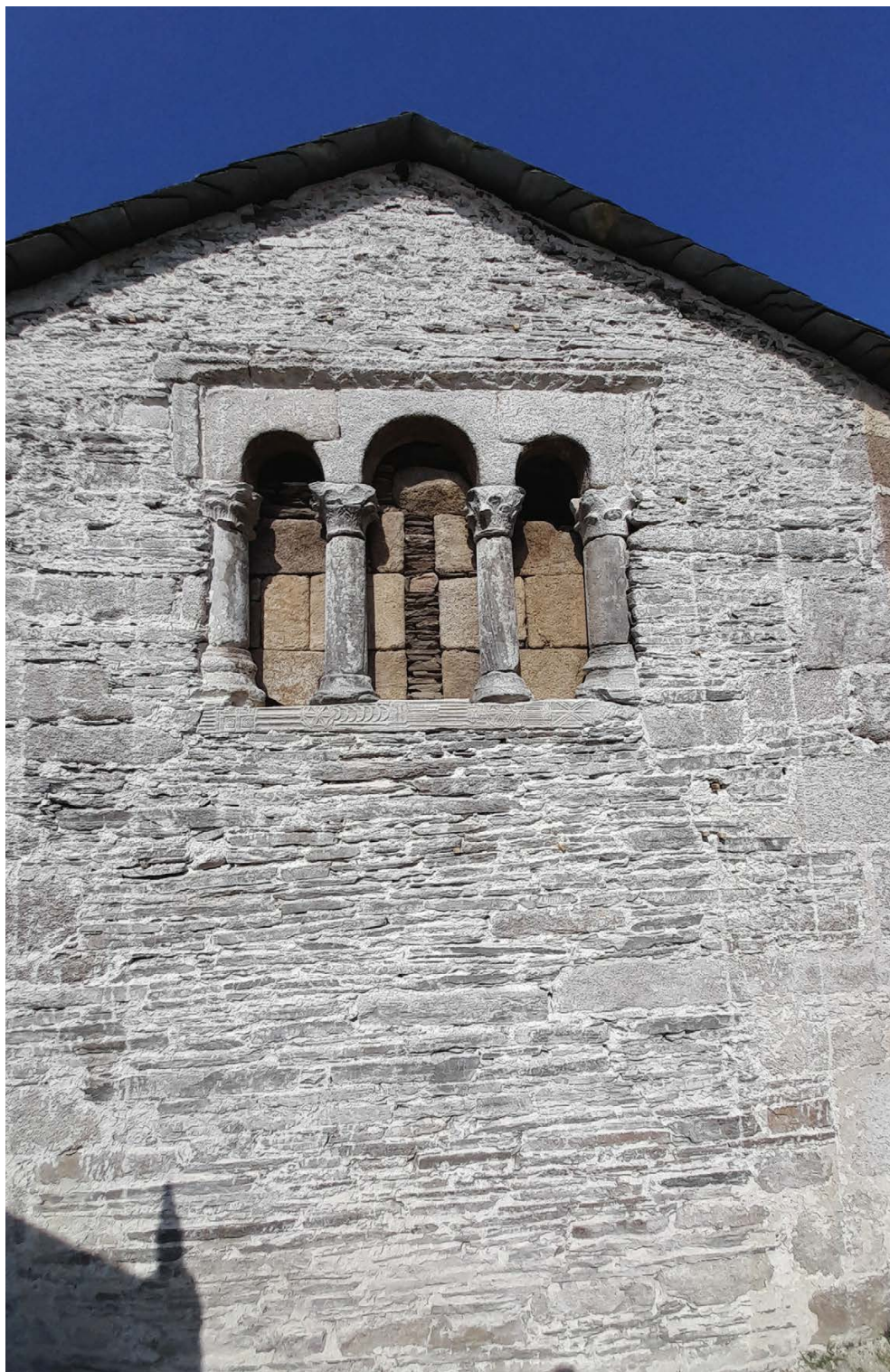
Fig. 16: Exterior del ábside (foto: autor).
