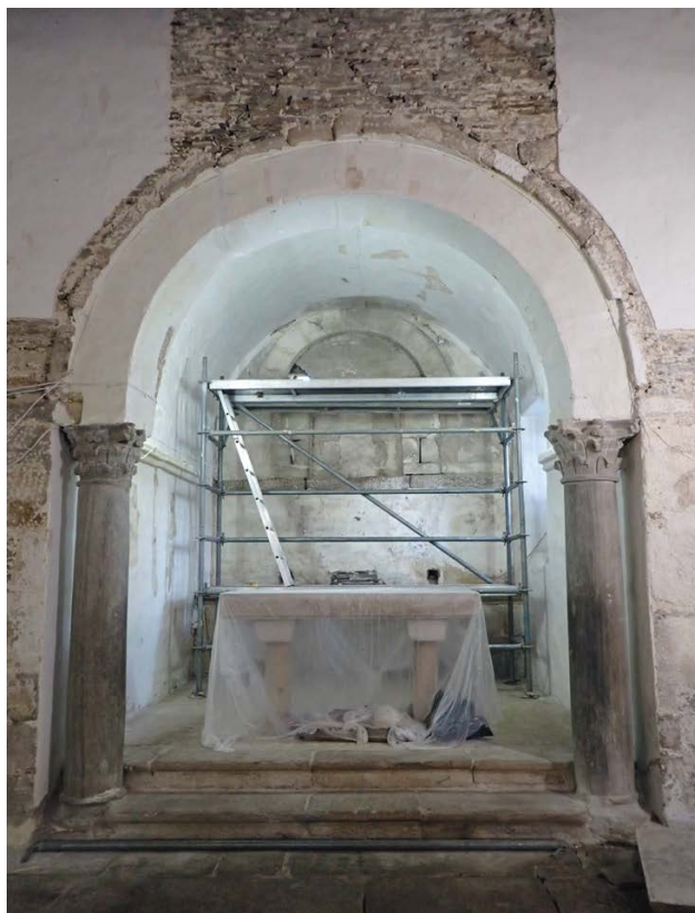
Fig. 2: Columnas romanas del arco triunfal (foto: Belén López Gallego).
