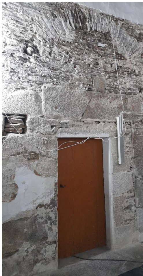
Fig. 12: Puerta de acceso a la "sacristía" norte (foto: autor).
