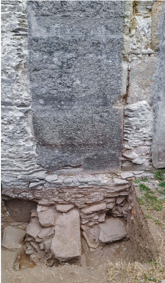
Fig. 7: Detalle de almohadillado de los pilares romanos (foto: autor).
