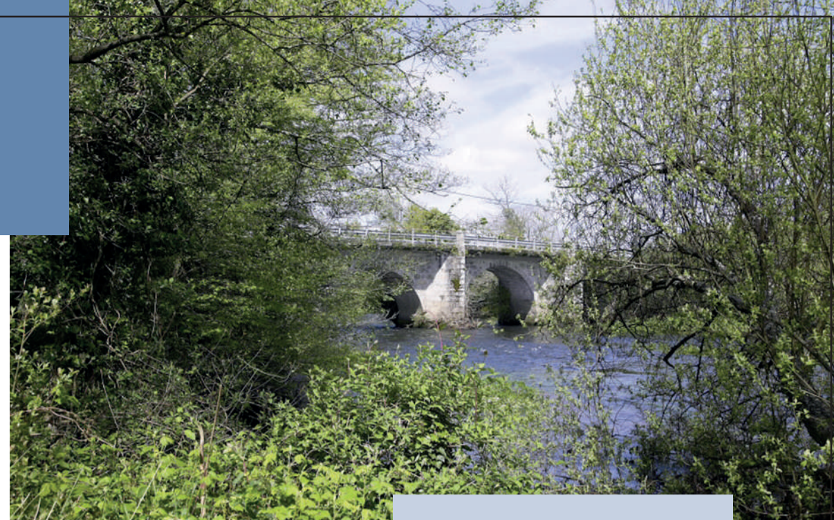
A Ponte Olveira, Mazaricos
