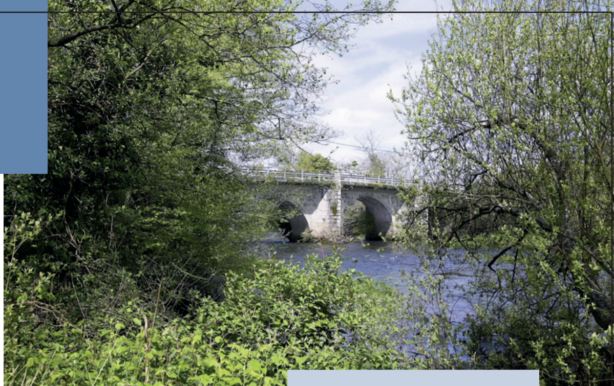
A Ponte Olveira, Mazaricos
