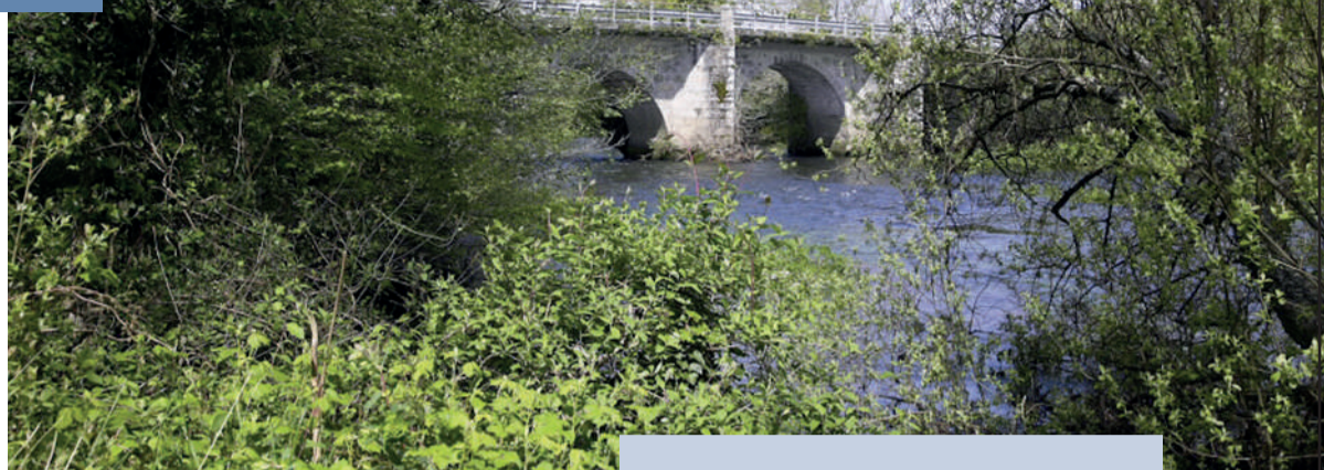
A Ponte Olveira, Mazaricos
