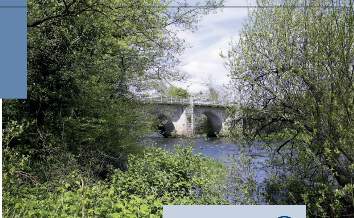
A Ponte Olveira, Mazaricos
