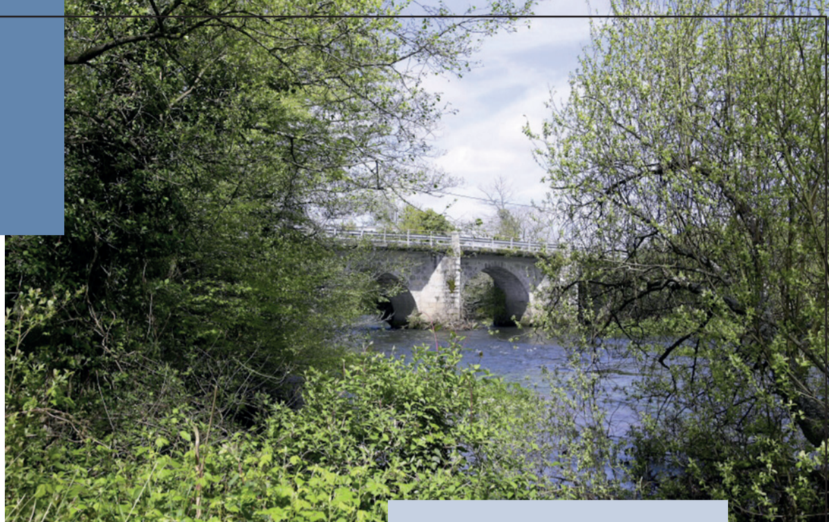
A Ponte Olveira, Mazaricos
