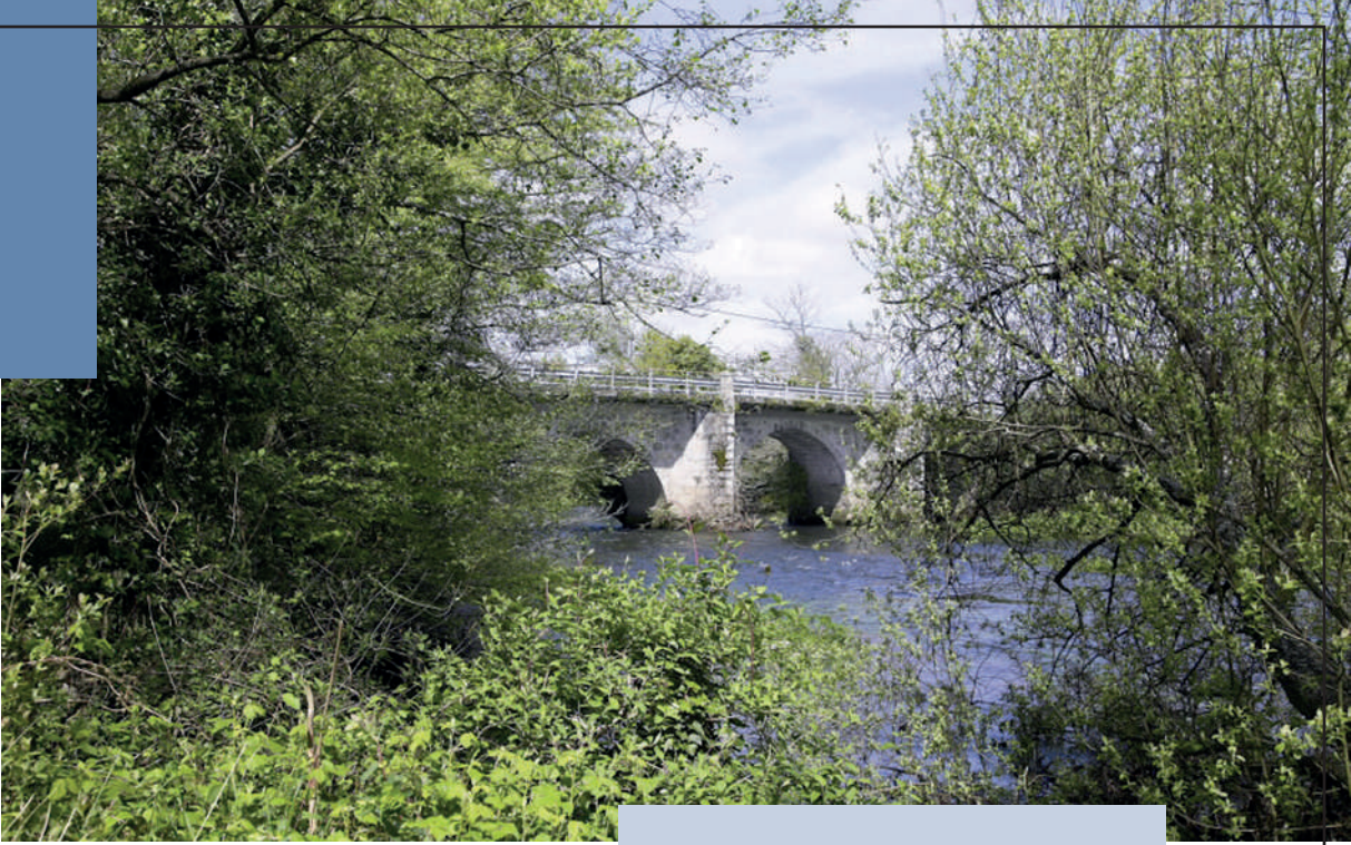
A Ponte Olveira, Mazaricos
