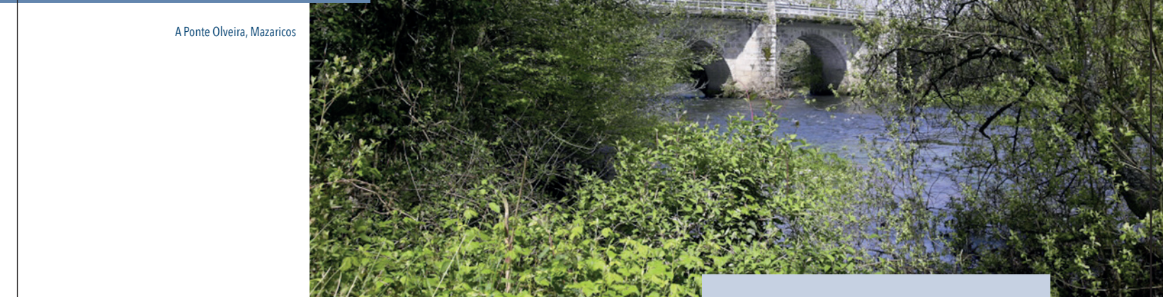
A Ponte Olveira, Mazaricos
