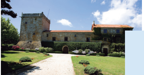
Tower of Xunqueiras
