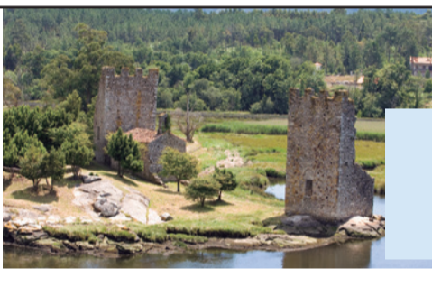
Torres de Oeste
