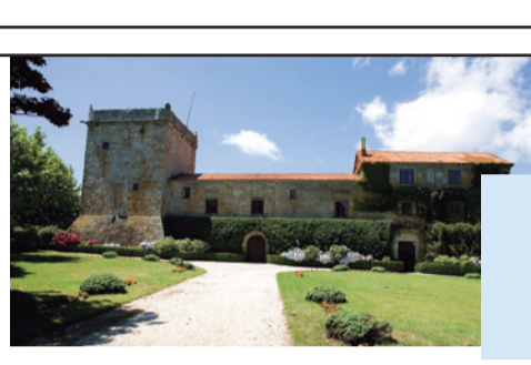
Torre de Xunqueiras
