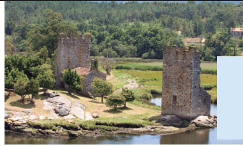
Torres de Oeste
