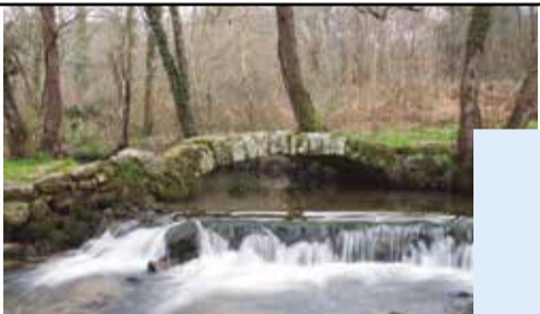
Puente en Rúa de Francos
