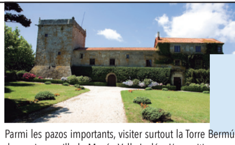
Torre de Xunqueiras
