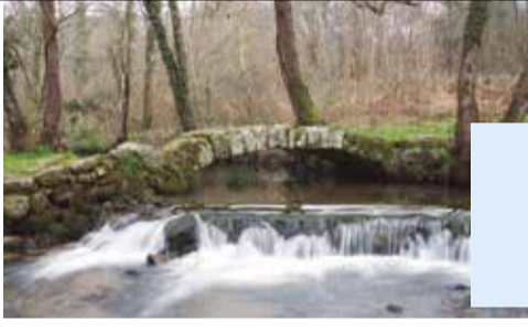
Pont de Rúa de Francos
