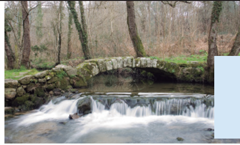
Ponte em Rúa de Francos
