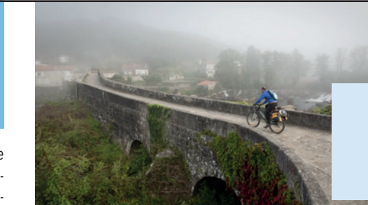
A Ponte Maceira
