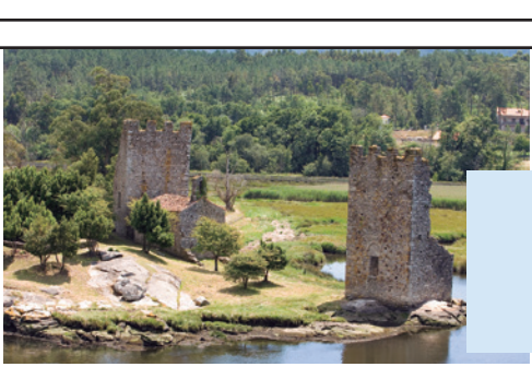
Torres de Oeste
