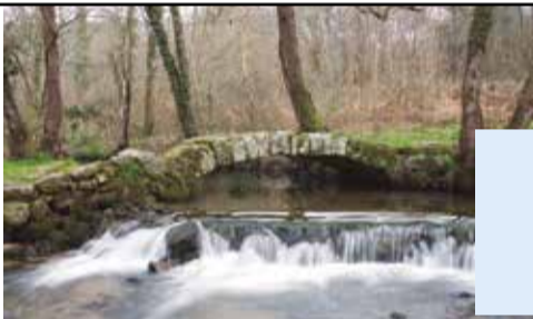
Ponte di Rúa de Francos
