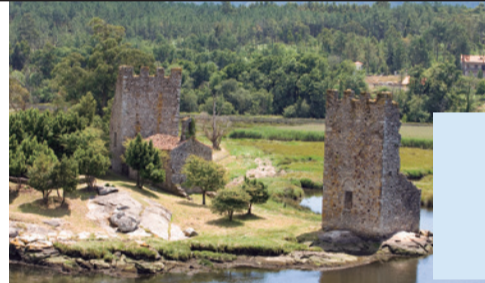
Torres de Oeste
