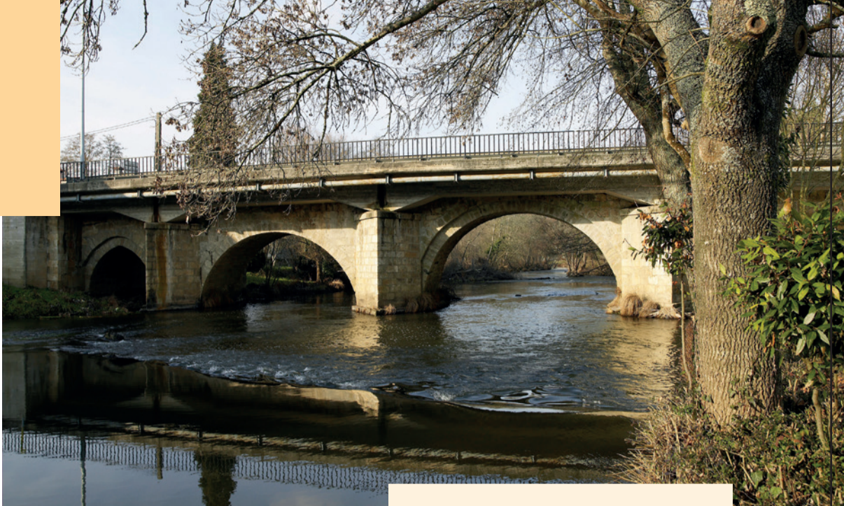
Brücke über den Fluss Tambre, Sigüeiro
