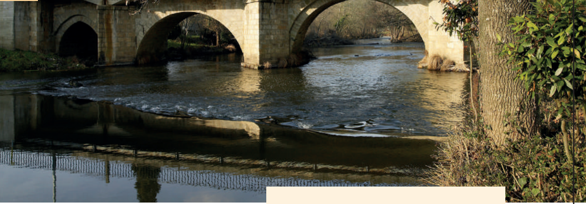
Brücke über den Fluss Tambre, Sigüeiro
