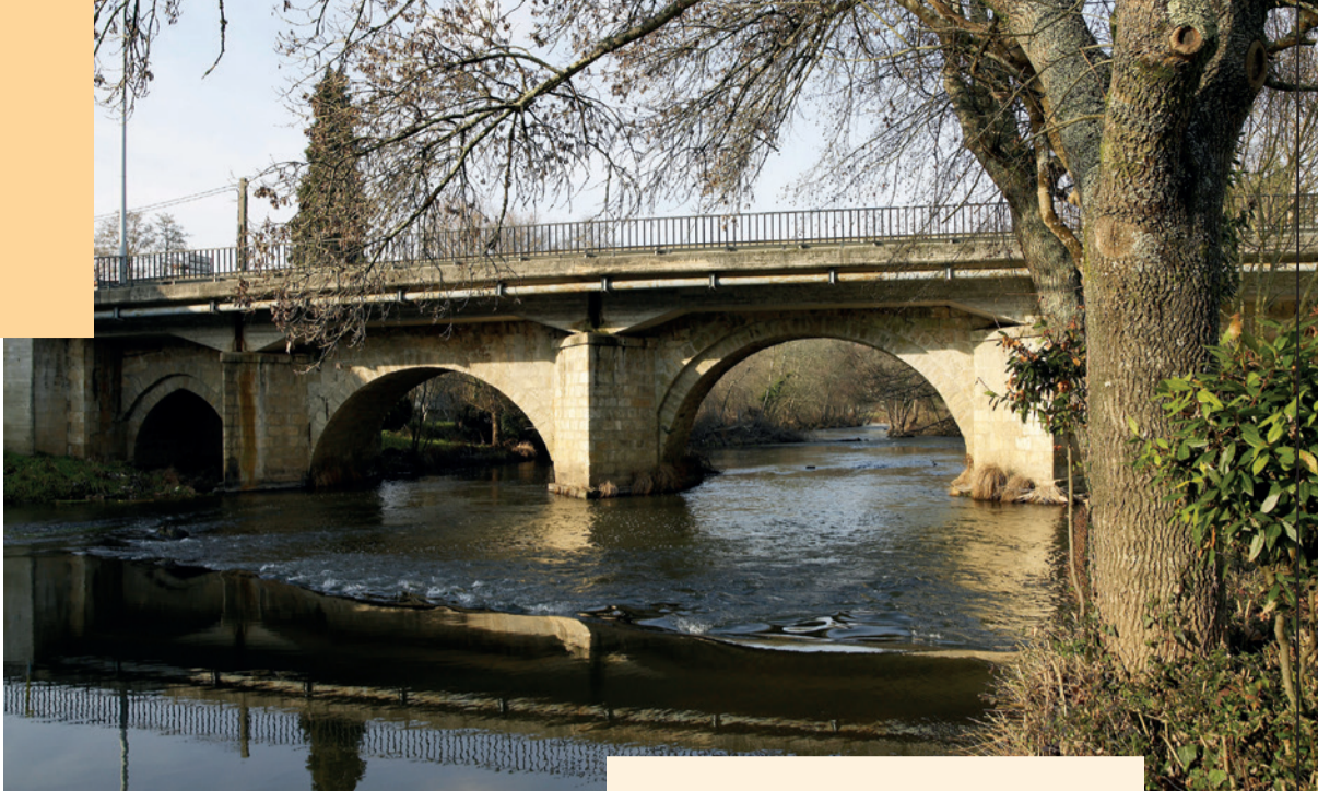
Puente sobre el río Tambre, Sigüeiro
