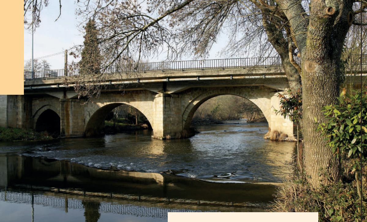
Puente sobre el río Tambre, Sigüeiro
