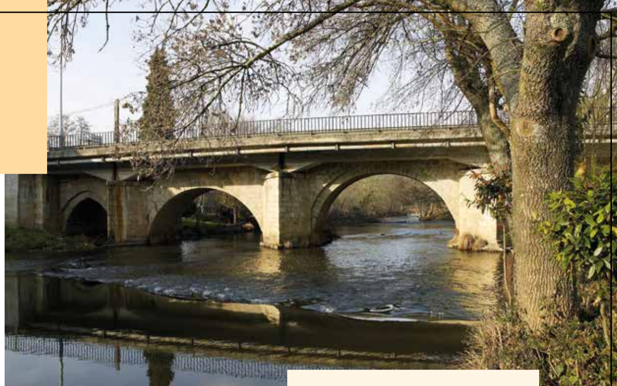
Puente sobre el río Tambre, Sigüeiro
