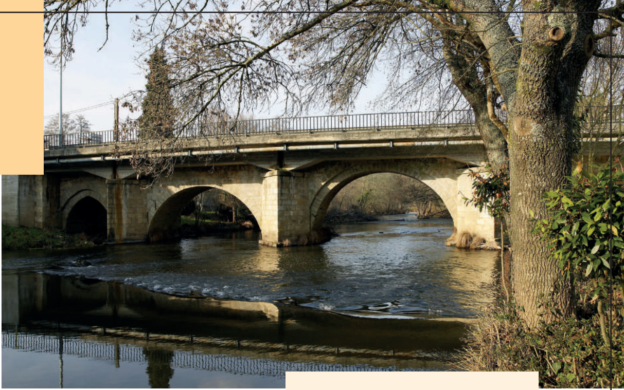
Ponte sobre o rio Tambre, Sigüeiro
