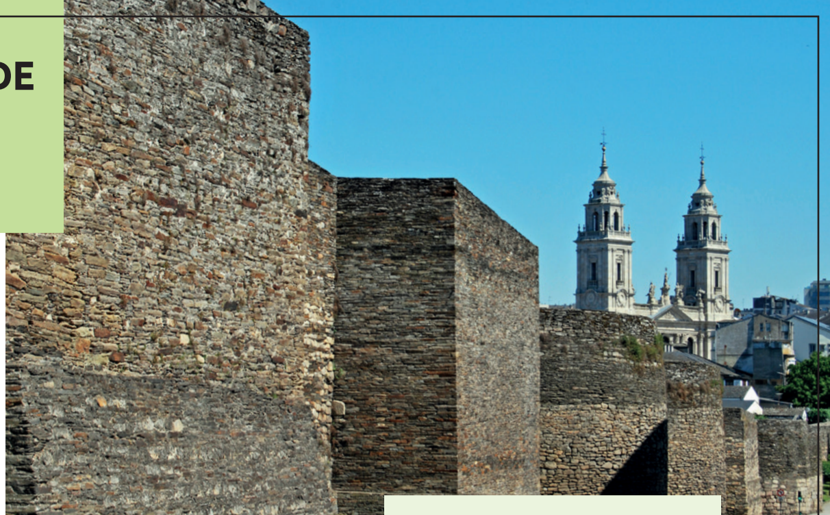
Stadtmauern und Kathedrale von Lugo
