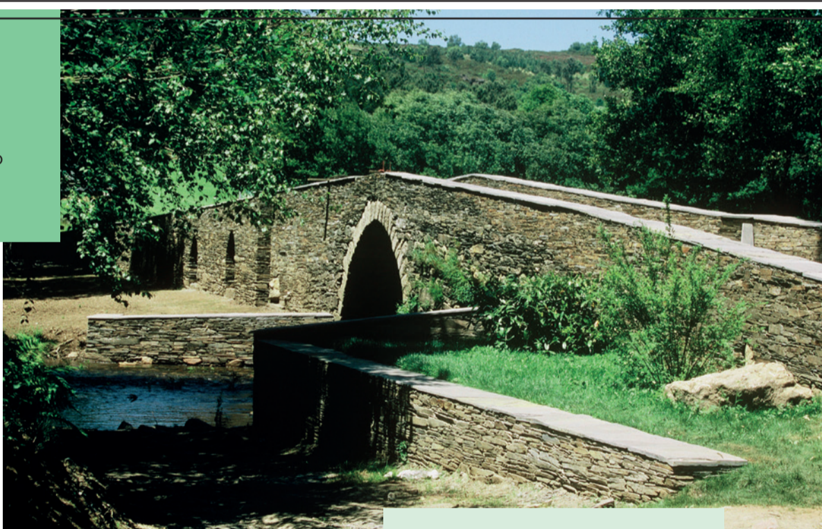
Saa Bridge, Vilalba
