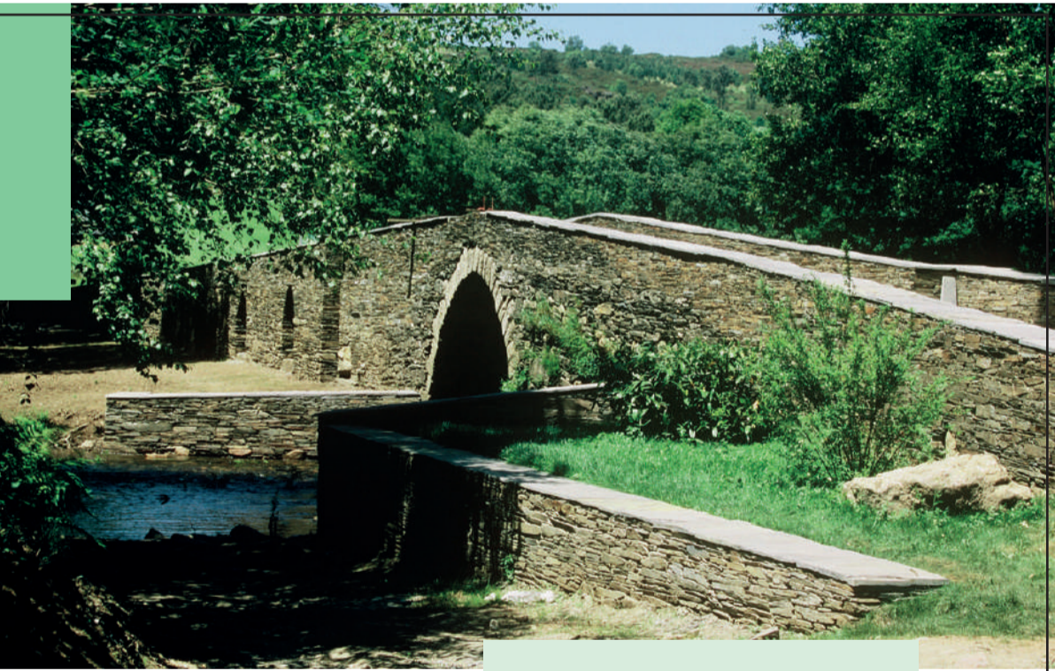
Ponte de Saa, Vilalba
