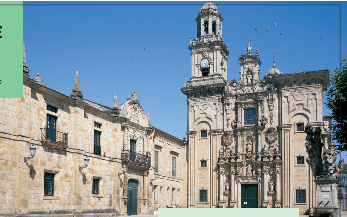
Monastério de Vilanova de Lourenzá
