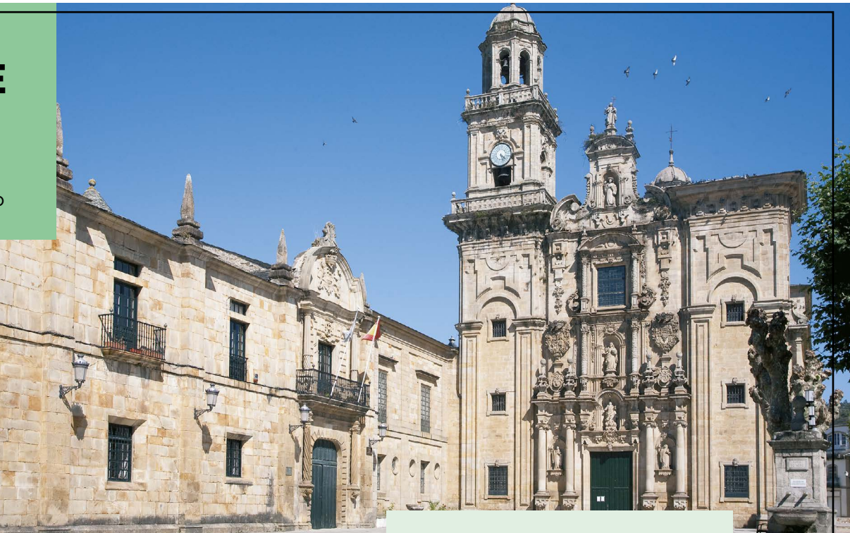
Monastério de Vilanova de Lourenzá
